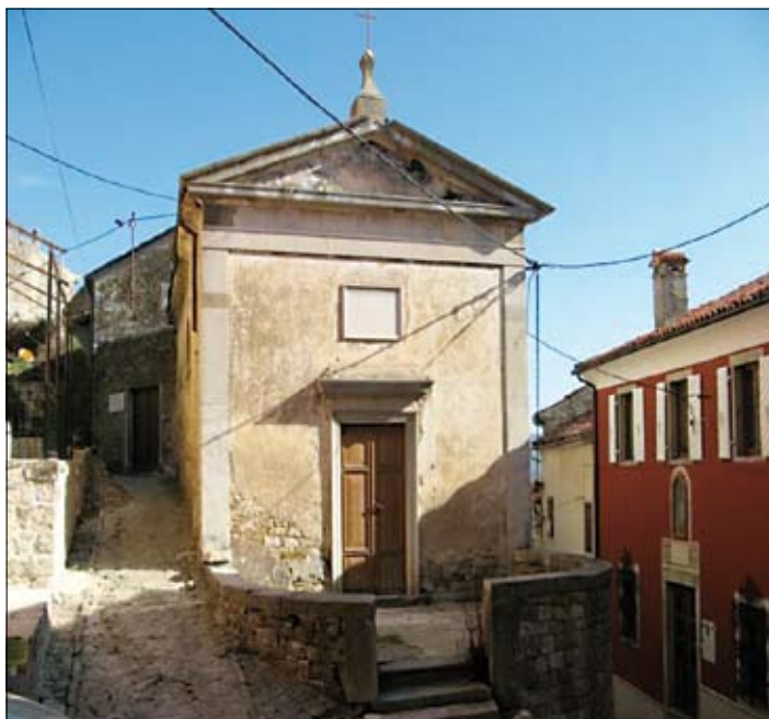
Fig. 2 - Montona: la chiesa di S. Cipriano con l'edificio che fu sede dell'omonimo ospizio (G.A.)
